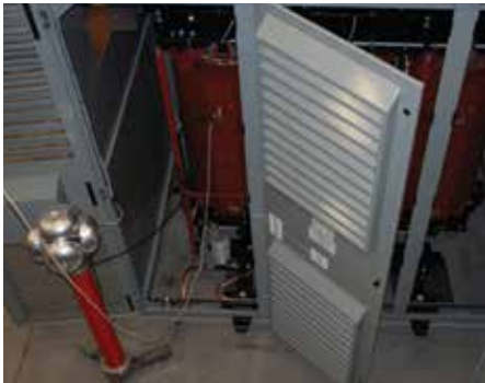
Nivel de Aislamiento Básico Por Impulsos
