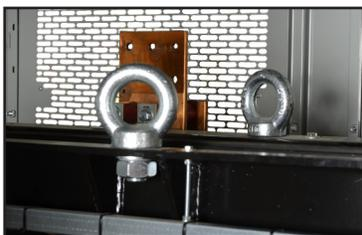
Agujeros de las armellas para el ensamblaje del núcleo y bobina
